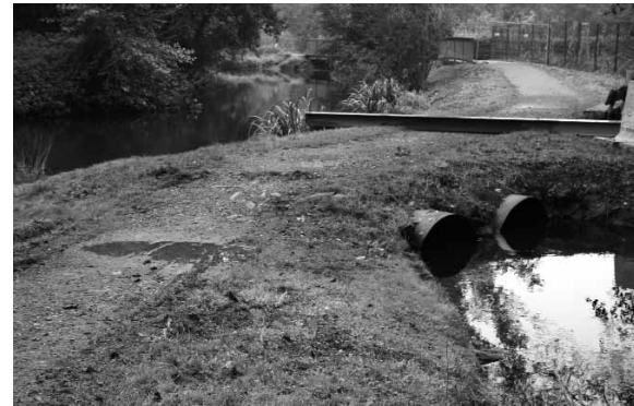
Vorher: verrohrte Flusseinmündung
