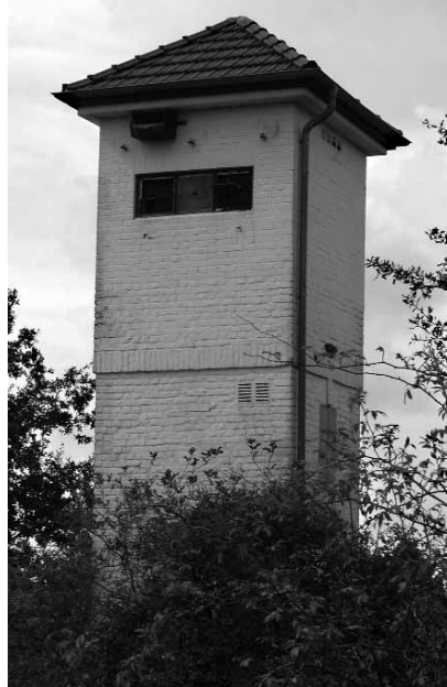
Der NABU-Trafoturm Fotos: Jochen Schages
