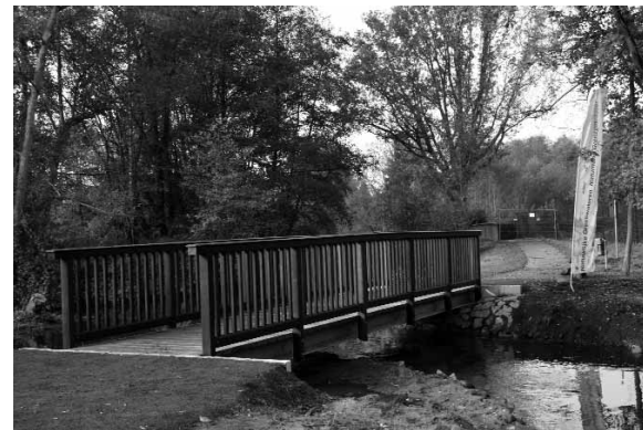
Nachher: Stahlrohre wurden durch offene Bauweise und Brücke ersetzt.
