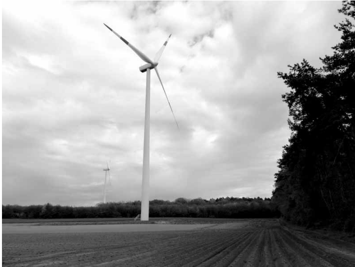
Diese Anlagen bei Oberkrüchten stehen jeweils nur knapp 70 m vom Waldrand und Gehölzen entfernt.
