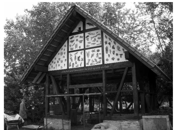
Der neue Fachwerk- unterstand im Bau Foto: Wiebke Esmann
